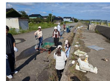
珠洲市沿岸部の側溝清掃
